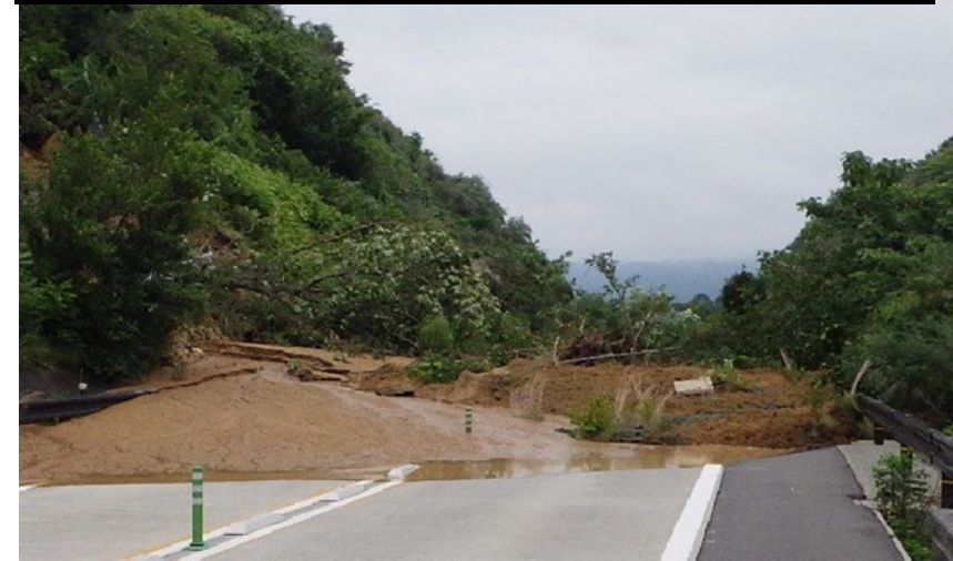
東広島・呉自動車道 平成30年7月10(火) 復旧
