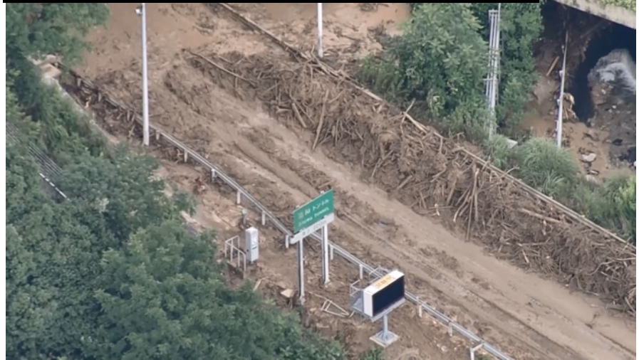
山陽自動車道 平成30年7月14日(土) 復旧
